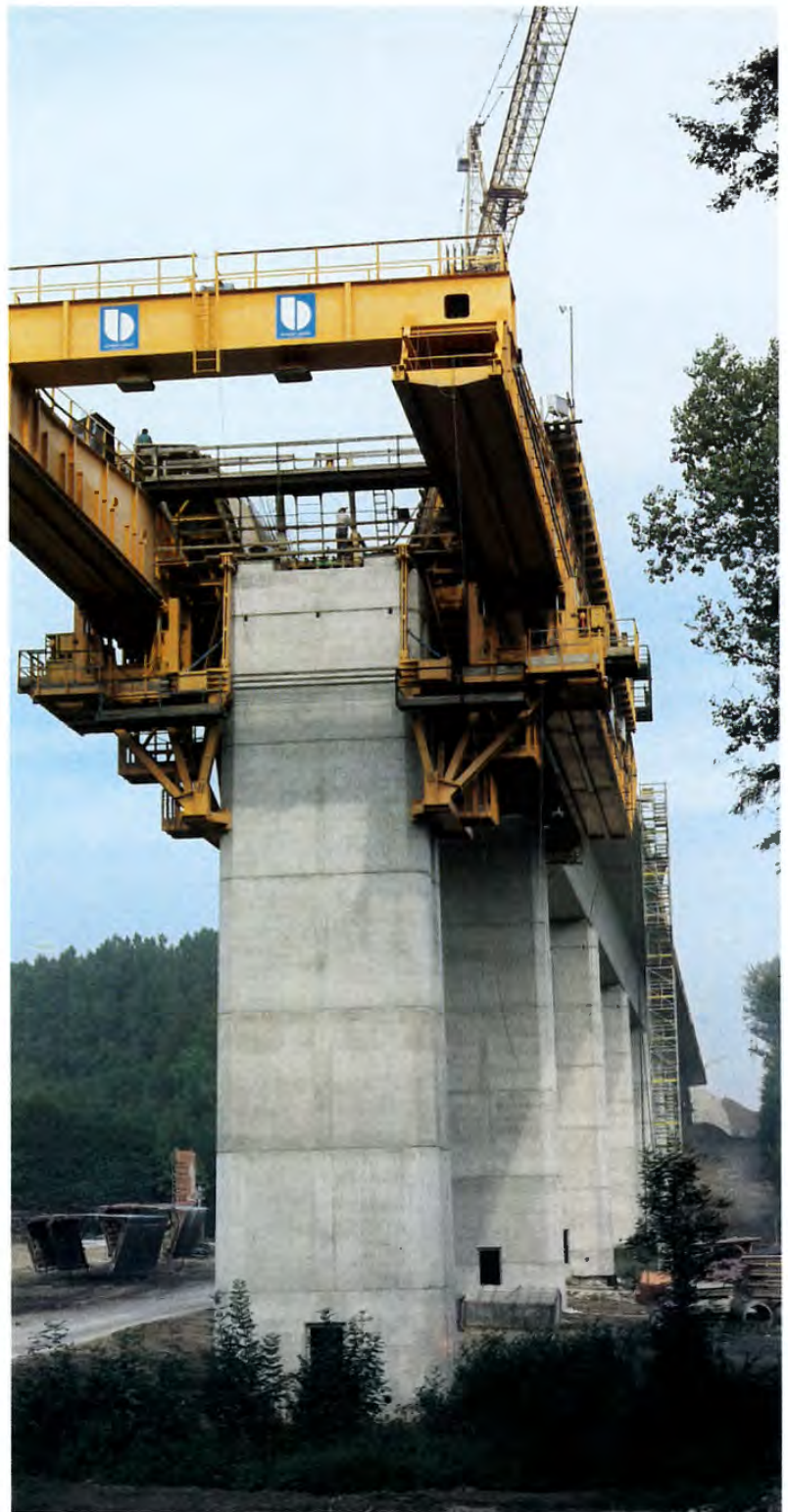
Bild 29: Überbauerstellung der Zigeunergraben-Talbrücke im Taktverfahren
