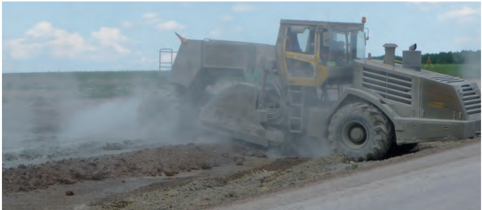
Abb. 7.13: VDE 8.2, NBS Erfurt–Halle/Leipzig – Einfräsen des hydraulischen Bindemittels in den Untergrund
