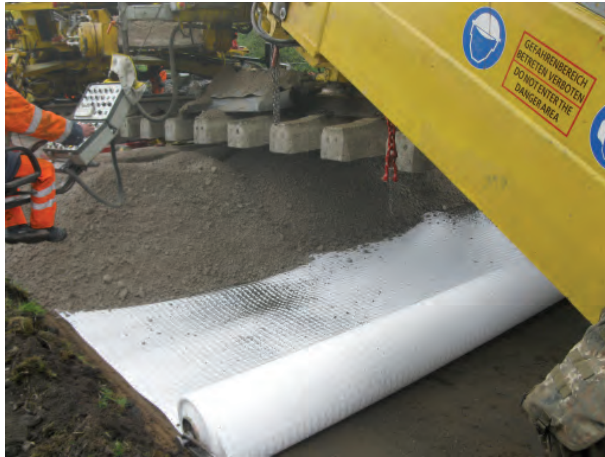
Abb. 8.27: Verlegen eines Geokunststoffs und Einbau der Schutzschicht
