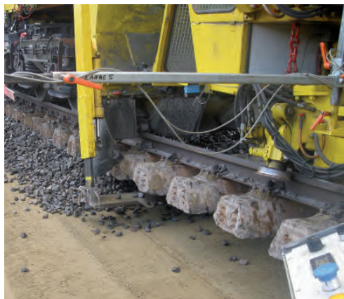
Abb. 8.29: Aufbringen des Neuschotterers
