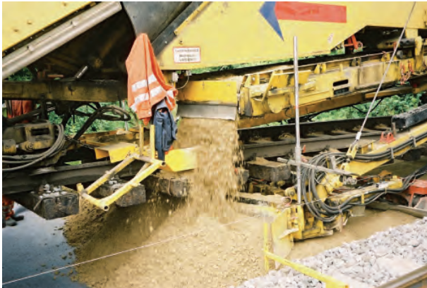
Abb. 8.28: Einbau der Schutzschicht und Verdichten
