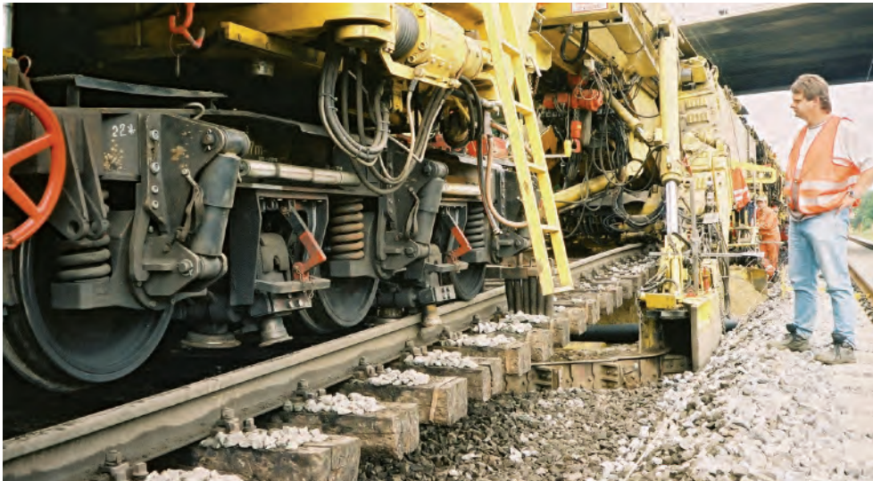
Abb. 8.26: Anheben des Gleises und Aushub des Altschotters
