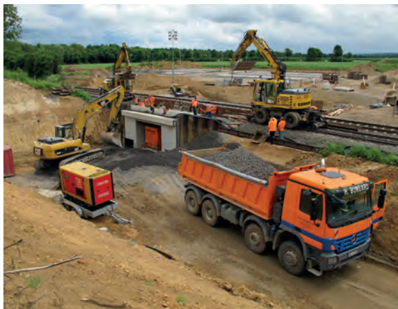
Rheinbach Römerkanal – Einschub des nördlichen Teils der Personenunterführung
