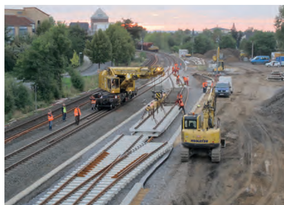
Bf Rheinbach – Weicheneinbau mit Gleiskran
