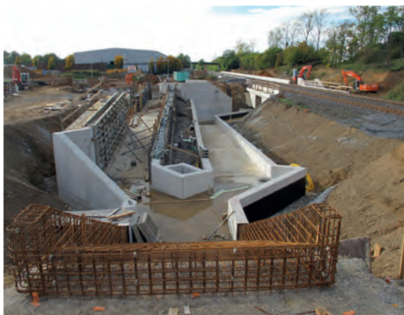
Rheinbach Römerkanal – Südlicher Zugang zur Personenunterführung im Rohbau
