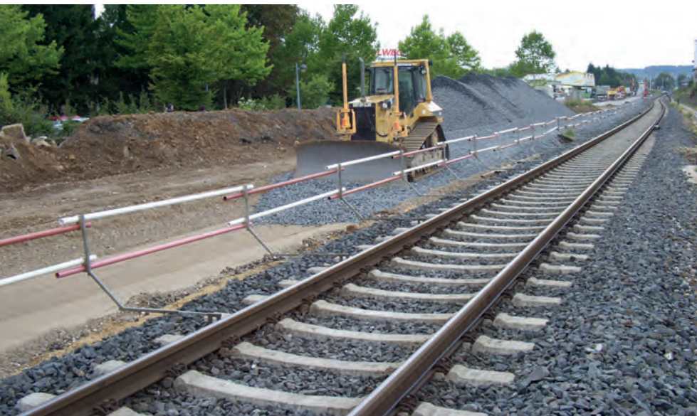
Erstellung des zweiten Streckengleises (September 2003)
