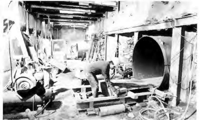
Herstellung der Rohrschirmdecke direkt unter Kellerfundamenten der östlichen Liegenschaften an der Ecke Bieberer-/Friedhofstraße; in diesem Bereich musste der hier nach Osten ansteigende S-Bahn-Tunnel unter den Gebäuden teils in bergmännischer Bauweise errichtet werden
