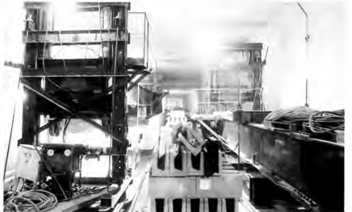
Hubgerüste zum Einbau der Lager für die ca. 10 Meter langen (Blocklänge) Masse-Tröge, die vor Ort auf der Tunnelsohle betoniert wurden; links Gerüst in Stellung Masse-Trog angehoben zum Lagereinbau, rechts in Stellung abgesenkt; nach Lagereinbau bilden Gleisrost, Schotterbett, Masse-Trog und Lager das Masse-Feder-System
