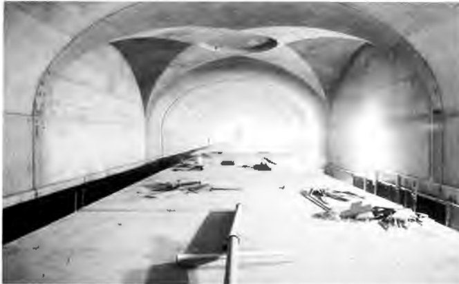
Stationsrohbau im Bahnsteigbereich: Die Ausbildung von Kreuzgewölben dient der optischen Gliederung der 210 Meter langen Mittelbahnsteige
