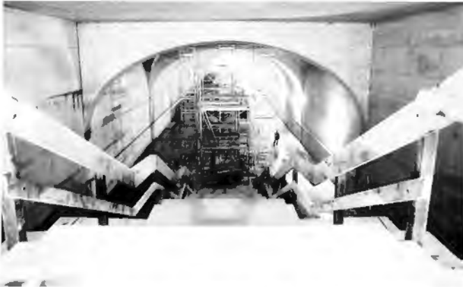
Bereits bei der Trassenfreimachung und der Rohbaukonzeption wurde der Grundstein für die übersichtliche und kostengünstige Ausbildung und Gestaltung aller unterirdischen Stationsbauten der City-Trasse Offenbach gelegt; Durchblick von einem Kopfzugang der Station zum anderen ist wesentlicher Bestandteil des Konzeptes zur Erhöhung der subjektiven Sicherheit der Reisenden bei unterirdischen Verkehrsbauten
