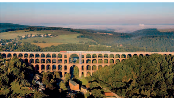
Bild 2: Die größte Ziegelbrücke der Welt, das Göltzschtalviadukt bei Reichenbach (Vogtland) – gebaut in den Jahren 1846 bis 1851 im Zuge der Sächsisch-Bayrischen Eisenbahn (Quelle: DB AG/Schmid)
