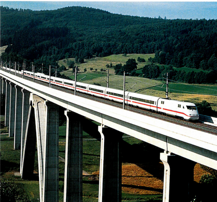
Bild 1: ICE-Zug auf der Neubaustrecke Hannover—Würzburg
