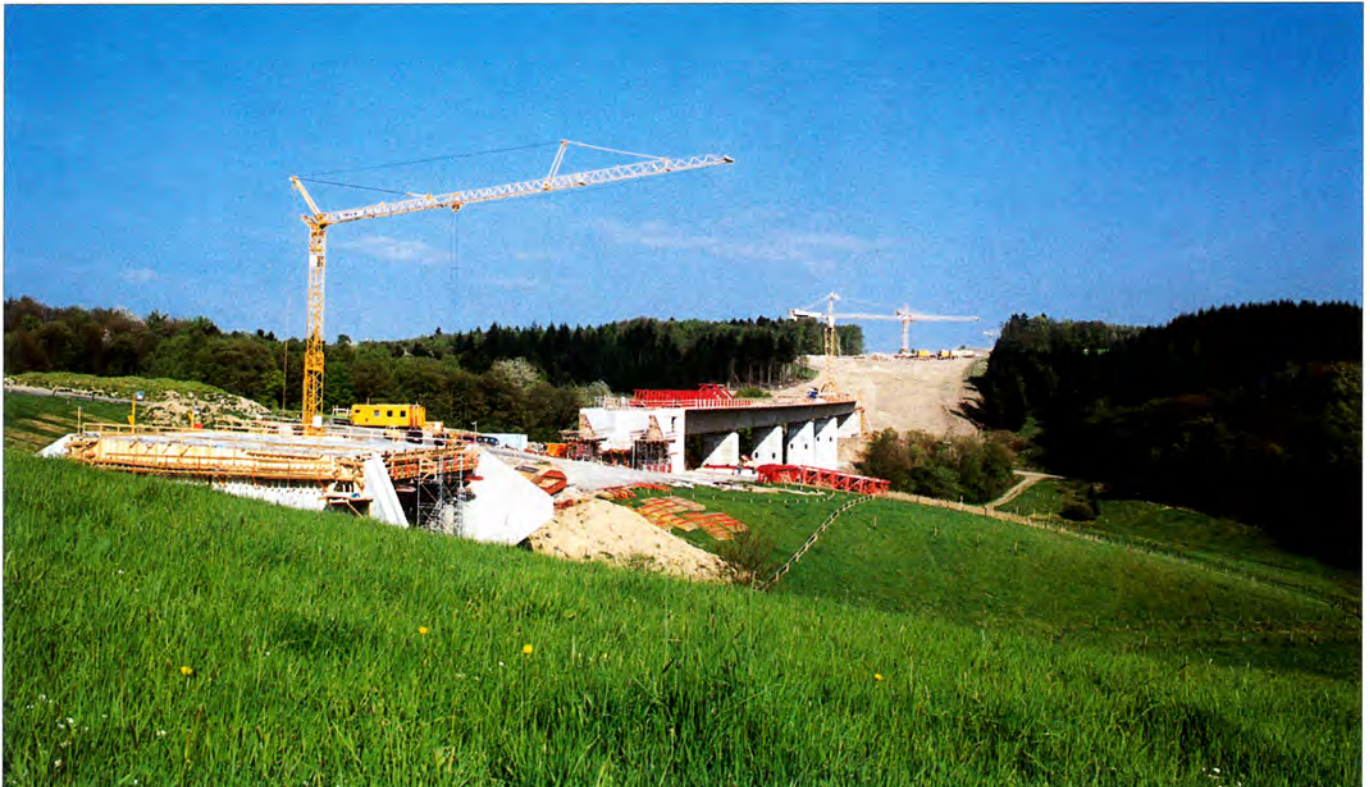
Die Dasbachtalbrücke (218 Meter) besteht aus 5 Feldern und ist bis zu 23 Meter hoch.
