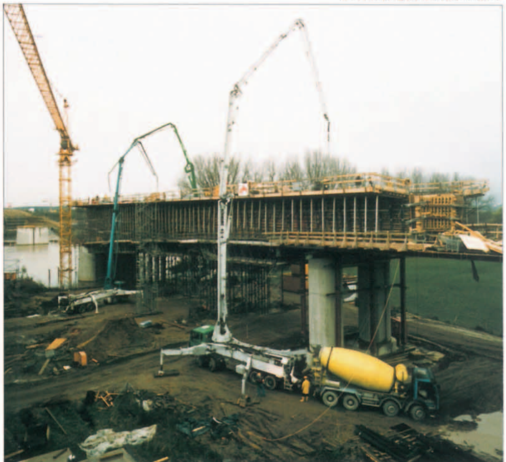
Herstellung der Vorlandfelder
