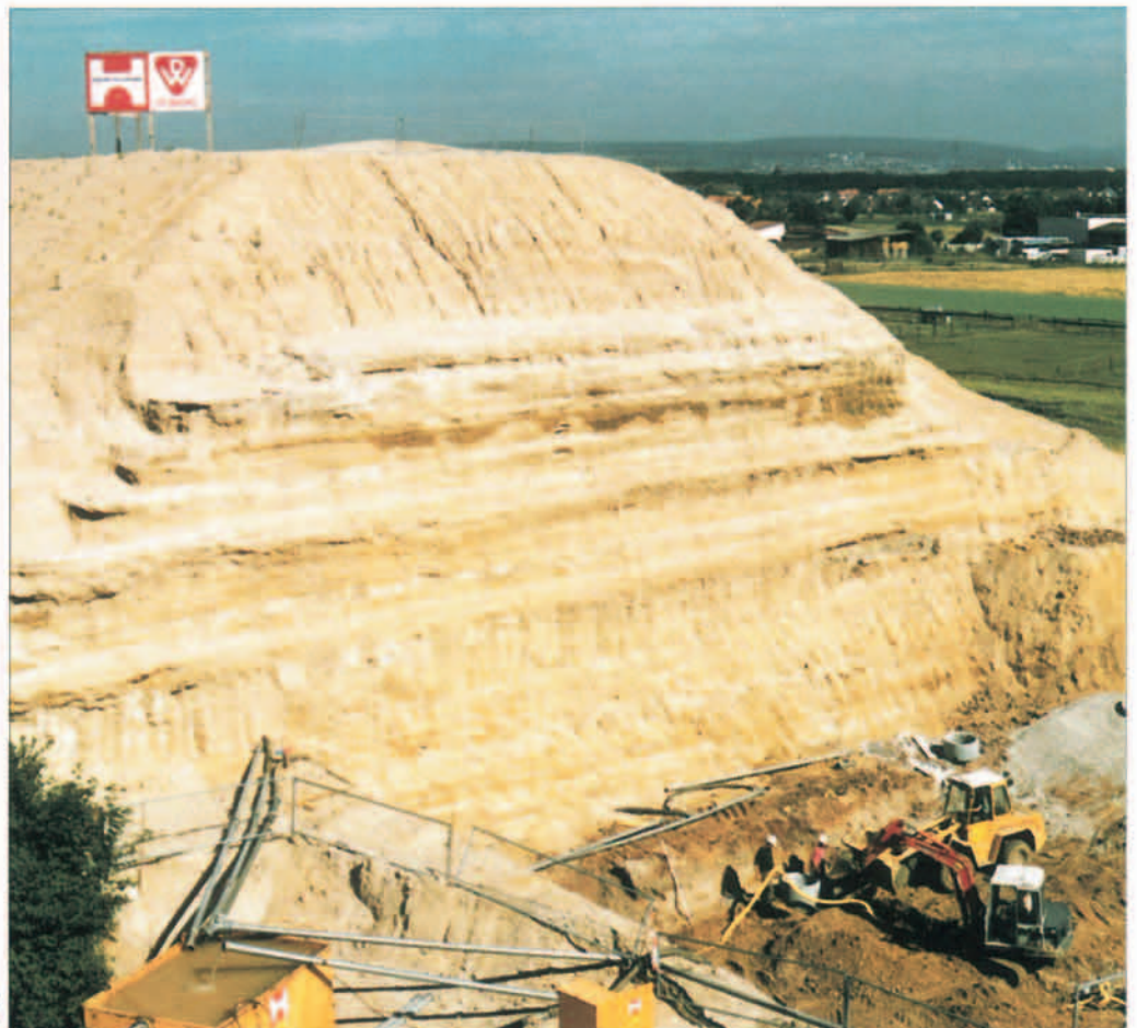
Zementverfestigte Schüttung hinter Widerlagern
