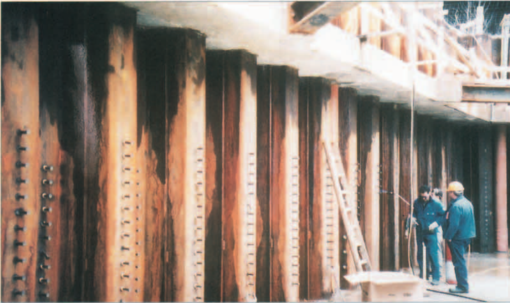
Anschließen der Kopfbolzendübel an die Spundwände
