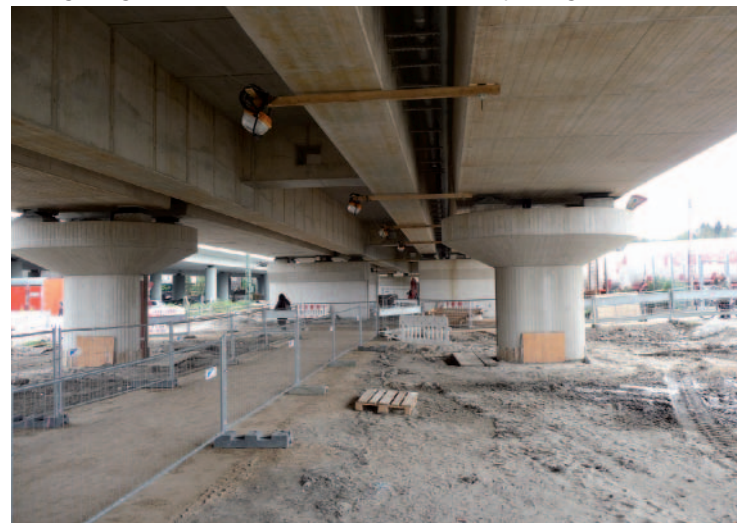
Auflagerung der Gleisbrücken im Bereich Deilbachquerung
