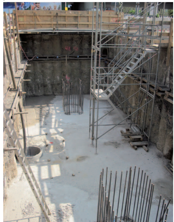
Pfeilergründungen im Schutz von überschnittenen Bohrpfehlwänden
