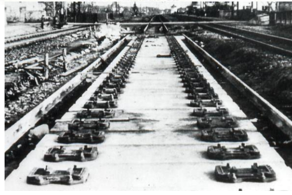
DB-Bauart 2 – Fertigteilplatte
